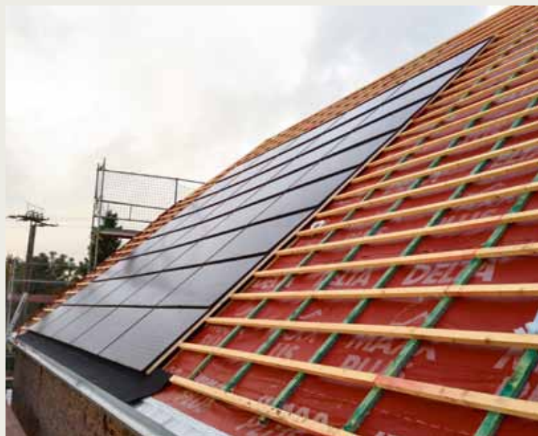
Im nächsten Schritt wurden die Modulplatten als Unterkonstruktion auf den Dachlatten befestigt. Die Verlegung der Module erfolgte von rechts nach links und von unten nach oben immer überdeckt, als regensichere Eindeckung.
