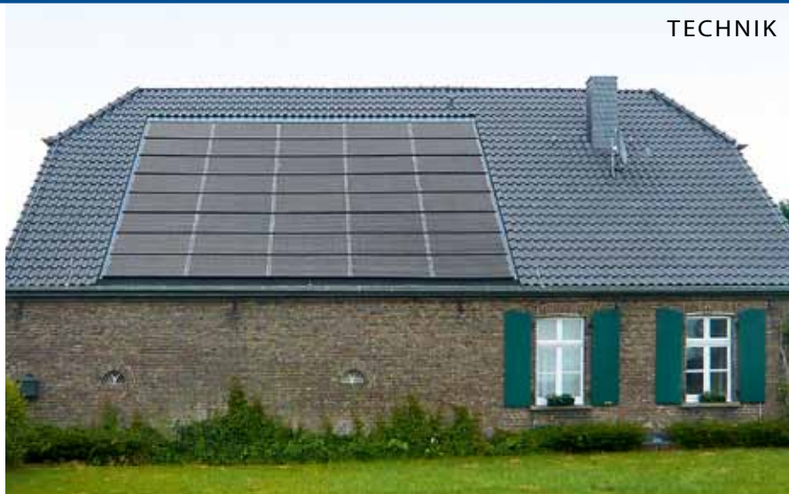
Nach der Fertigstellung: Die dunklen Module passen bestens zum Deckbild der dunkel engobierten Hohlziegel.
