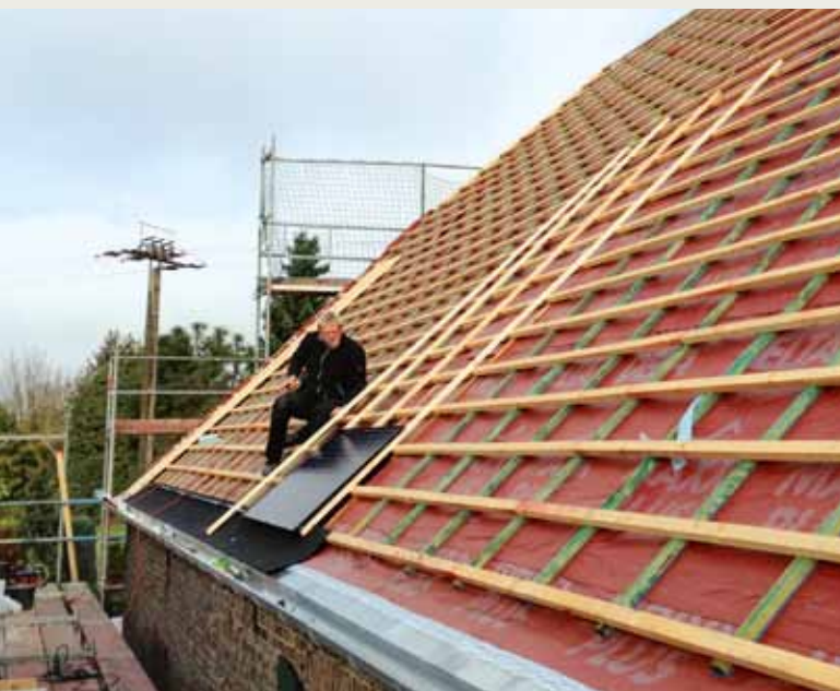
Nach dem Abriss folgte der Aufbau: im vordefinierten Feld auf der Südseite des Gebäudes richten die Dachhandwerker die hölzerne Unterkonstruktion aus, um so die optimale Lage für das Modulfeld zu bestimmen.
